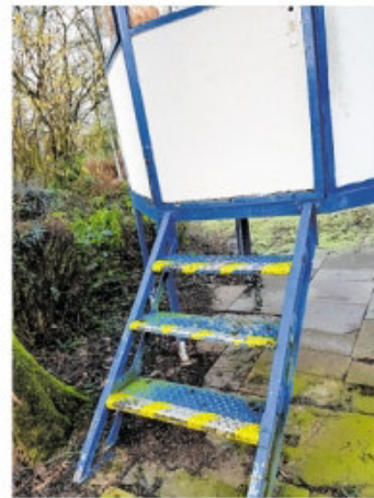
Die alte Treppe des Schwimmleisterturms wurde ersetzt.
