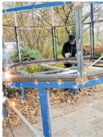
Der Turm wurde komplett in der Saisonpause neu aufgebaut.
