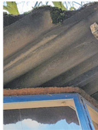
Auch das alte Dach des Turms ist ausgetauscht worden.
