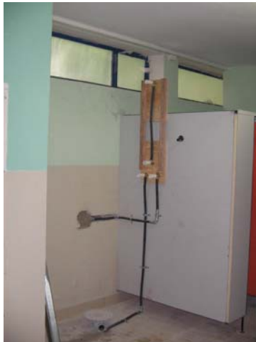
Dusche im Bau befindlich
